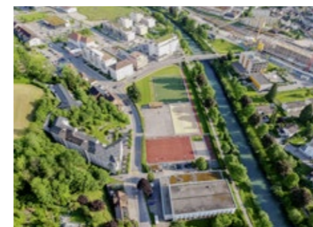
Auf diesem Areal entsteht die Kantonsschule.
